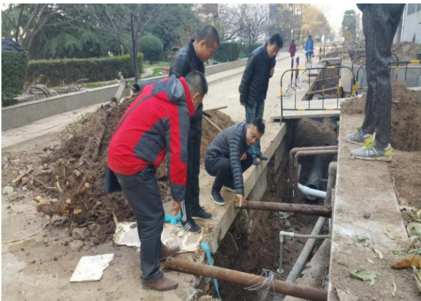
后勤管理处领导查看现场管线情况
