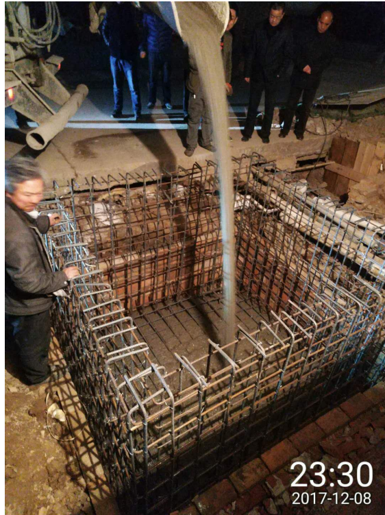
浇筑混凝土底板
